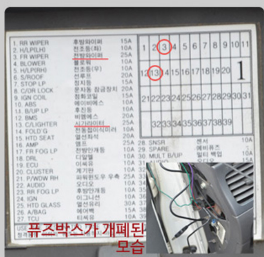
7. 퓨즈박스 뚜껑 안쪽에 퓨즈번호를 확인하여 안전소켓을 연결합니다. 주의! 전방 와이퍼 또는 시거잭 단자에 연결하시기 바랍니다. 차량마다 퓨즈번호가 다르기 때문에 꼭 번호를 확인하시고 설치하시기 바랍니다.
