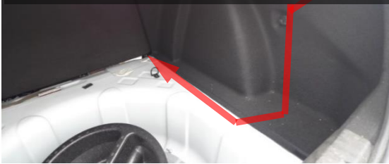
트렁크 라인을 따라 케이블 배선한다,
